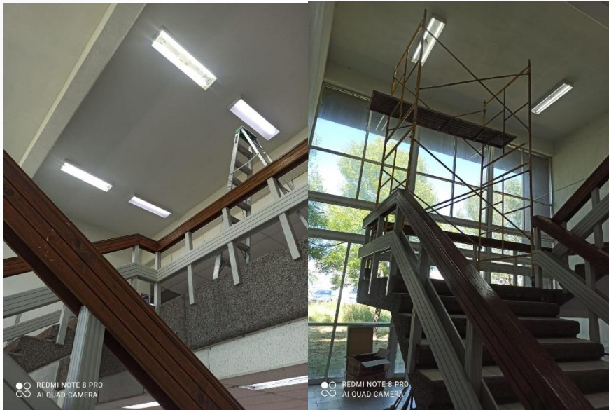
Cambio de focos en luminarias de escalera en edificio "M"
