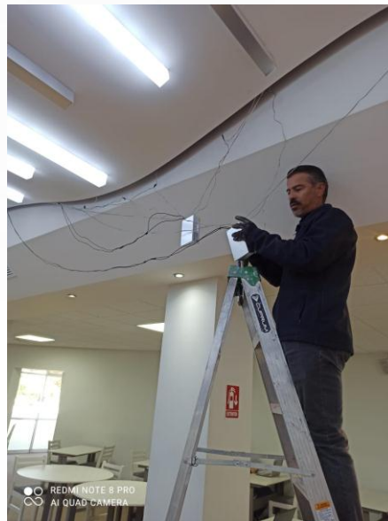
Cambio de balastras en lámparas led en Centro de Información
