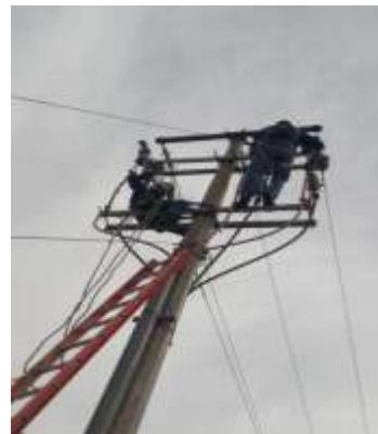
Mantenimiento a líneas de alta tensión
