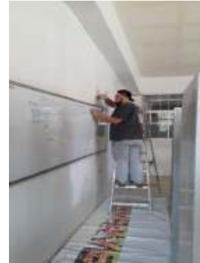
Pintura interior en aulas
