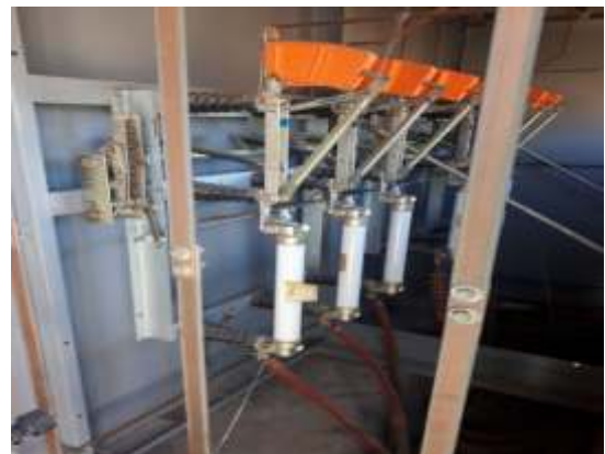
Mantenimiento a devanados en subestaciones eléctricas
