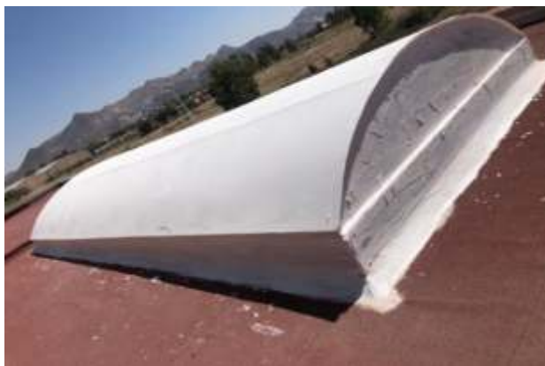
Impermeabilización de 3 domos en Centro de Innovación
